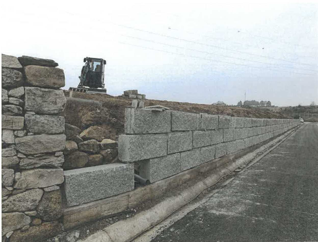
Fotografia 3: Muro em pedra de granito confinante com a via pública (EM 632-1), Marzagão – vista Sul Coordenadas GPS: 41.218747, -7.318126
