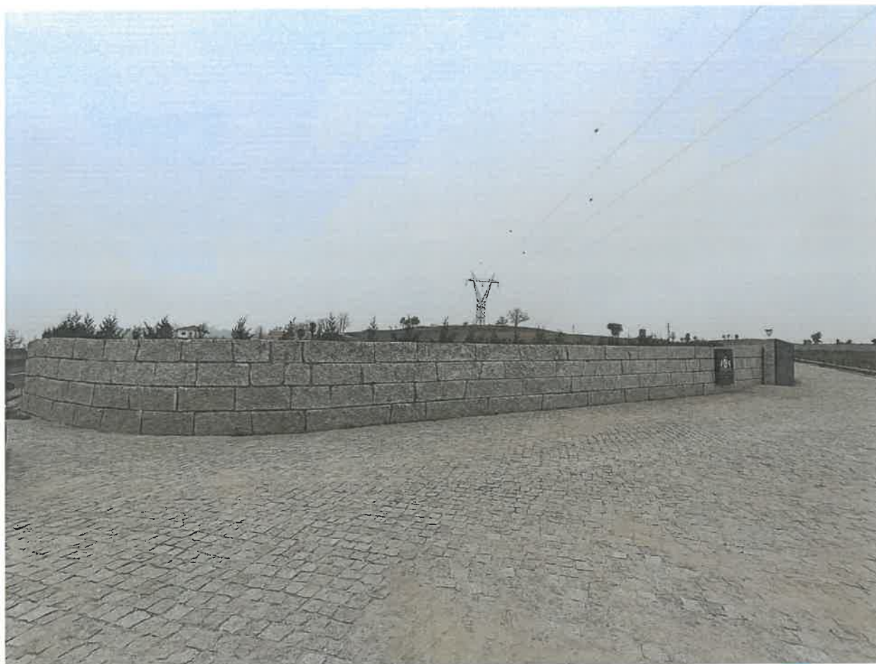
Fotografia 1: Muro em pedra de granito confinante com a via pública (EM 632-1), Marzagão – vista Norte Coordenadas GPS: 41.218747, -7.318126
