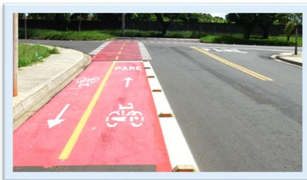
Exemplos de marcação horizontal e instalação de pilaretes flexíveis para garantir a segurança dos ciclistas
